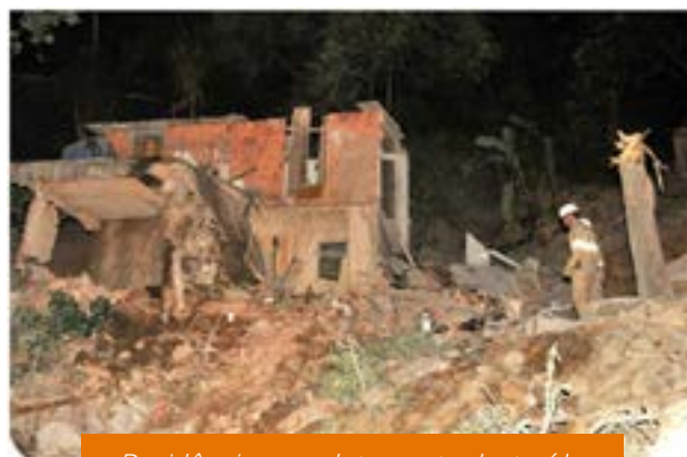
Residência completamente destruída.
