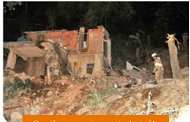
Residência completamente destruída.
